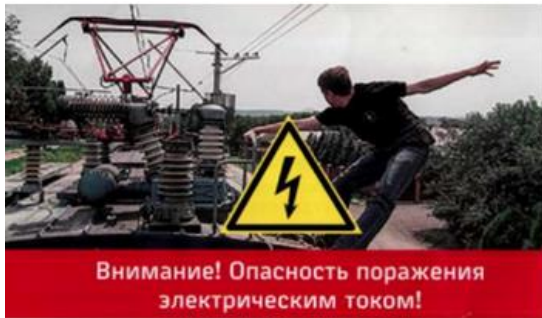
Напряжение контактной сети - 27500 вольт
